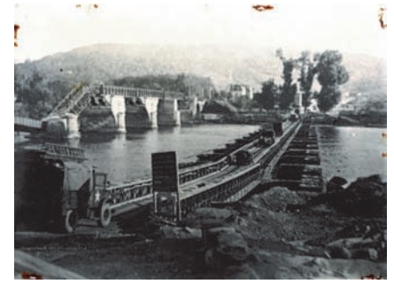
Pont de bateaux construit sur la Seine à Vernon par les Américains, 26 août 1944 (AD Eure, 17 Fi 53)
